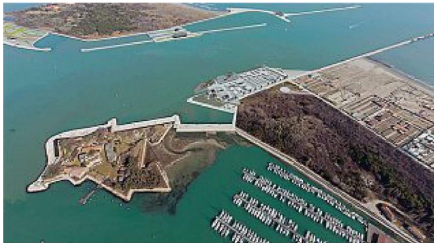
Il forte e il porto Una vista dall'alto della bocca di porto di Chioggia con i cantieri del Mose
